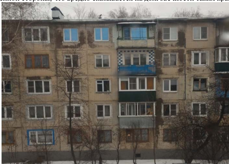
Рисунок 3 - Увлажнение стен 5-этажного жилого дома с бесчердачным типом покрытия
