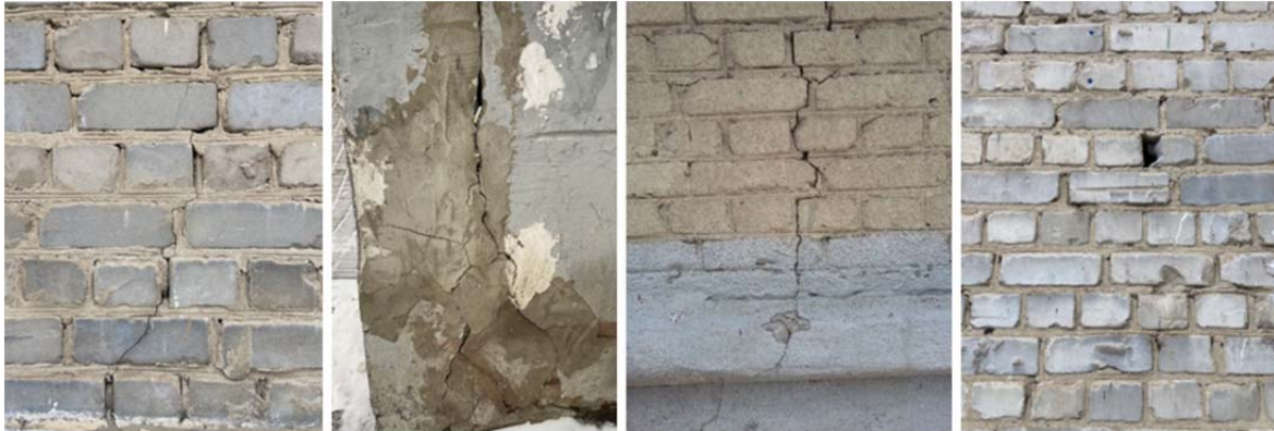
Рисунок 1 – Дефекты несущих и самонесущих стен
