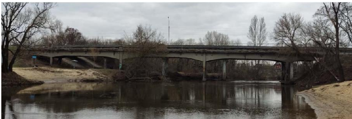
Рисунок 1 – Общий вид фасада моста через р. Цна
