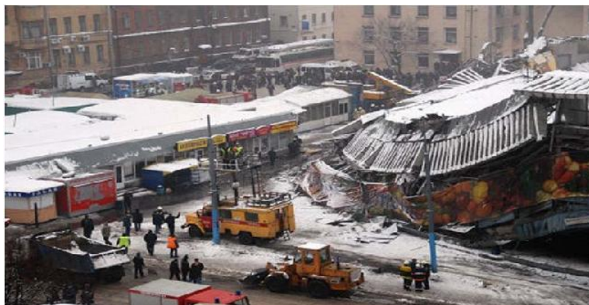
Рисунок 4 - Обрушение Басманного рынка в г. Москва
