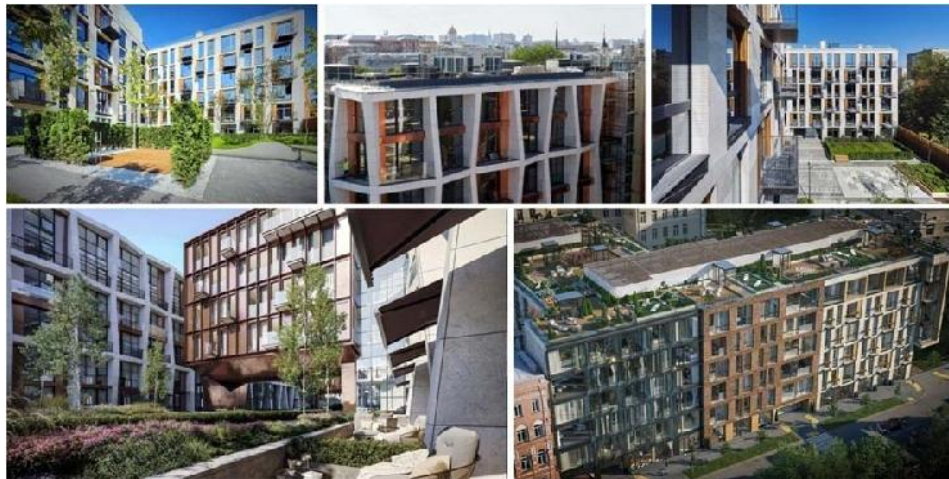
Рисунок 1 - Элитный жилой комплекс Ordynka, ул. Малая Ордынка, 25, г.Москва
