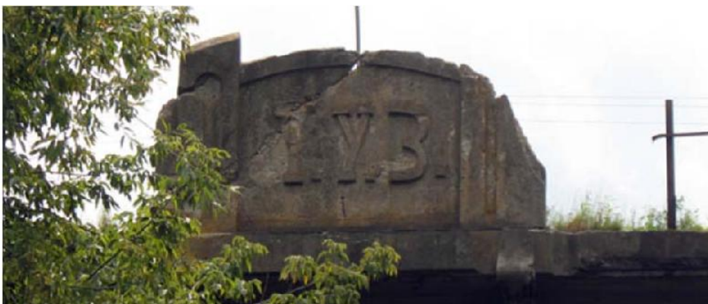
Рисунок 5 – Надпись «Т.У.З» Тамбовское уездное земство на сохранившемся элементе ограждения моста.
