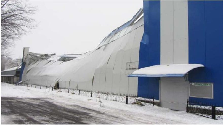
Рисунок 1 - Обрушение спортивного комплекса в г. Полтава, Украина
