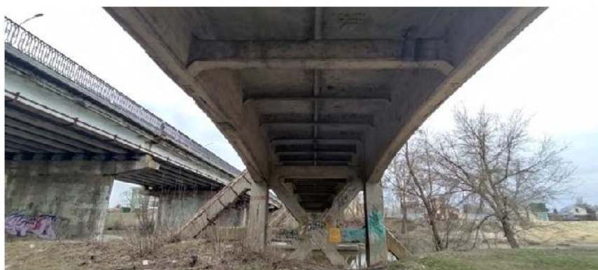
Рисунок 3, 4 – Общий вид и характерное состояние пролётного строения и опор моста.
