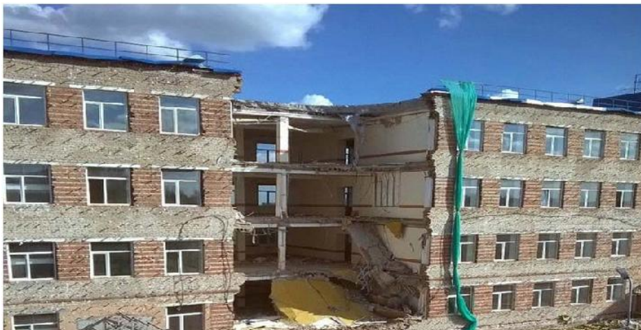
Рисунок 2 - Обрушение казармы учебного центра ВДВ в п. Светлый
