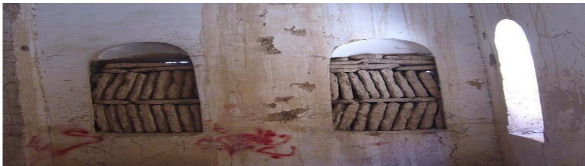
Фото 7 – Кирпичи, использованные для возведения зданий
