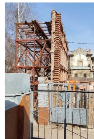
Рисунок 3 - ОКН из деревянных срубов, обложенных кирпичом: а - характерное техническое состояние неэксплуатируемых жилых зданий; б – работы по сохранению внешнего облицовочного слоя из кирпича
