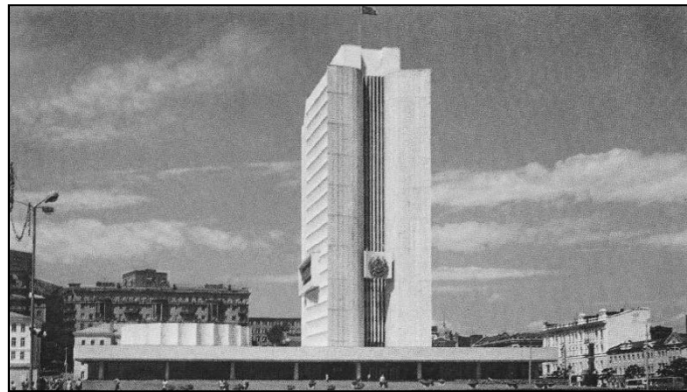
Рисунок 5 - Владивосток. Дом Советов. Арх. Е. Розанов, В. Шестопапов, Ю. Болдычев, 1982 г. Общий вид
