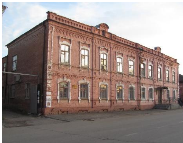
Рисунок 11 - Здание объект культурного наследия «Особняк Карле», г. Маркс, Саратовской области. При приспособлении здания под поликлинику выполнена пристройка с главным фасадом идентичным объекту культурного наследия. В настоящее время здание реставрируется с приспособлением под краеведческий музей г. Маркса
