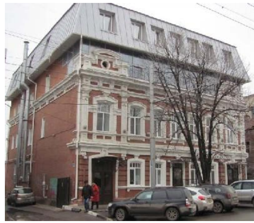
Рисунок 6 - Изменение функционального назначения здания объекта культурного наследия путем надстройки этажей, г. Саратов
