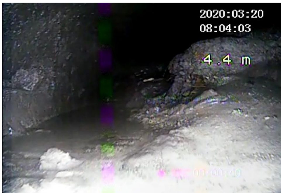
Рисунок 1 – Заиливание ливневого коллектора, расположенного по Комсомольской площади.
