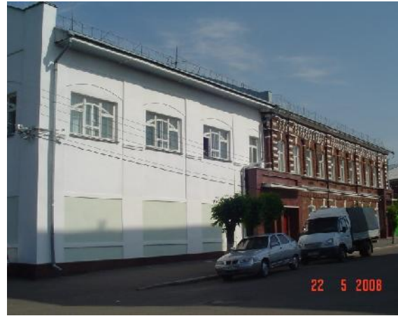
Рисунок 8 - Изменение функционального назначения здания объекта культурного наследия путем пристройки. Здание РКЦ Банка России в г. Мичуринске Тамбовской области
