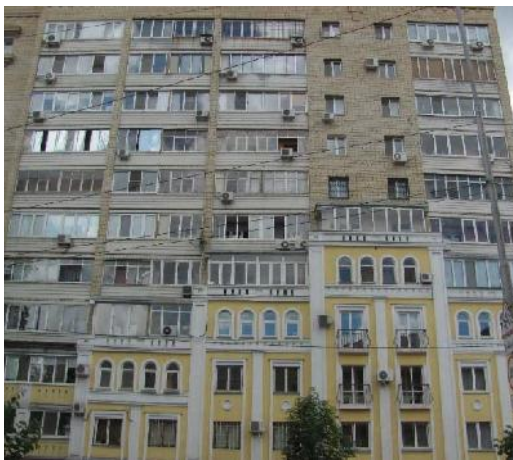
Рисунок 3 - Трансформация фасада здания объекта культурного наследия при изменении назначения здания. Жилой дом, г. Саратов
