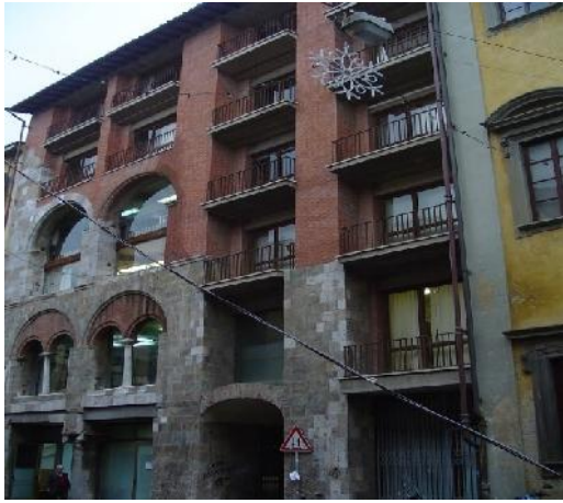
Рисунок 1 - Пример надстройки здания объекта культурного наследия жилого дома в г. Милан, Италия
