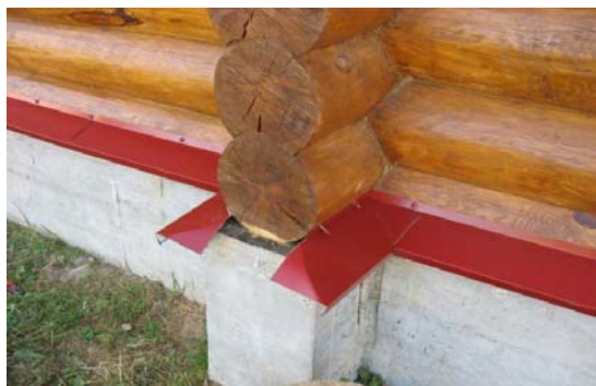
Рисунок 3 – Установка металлического отлива на сруб
