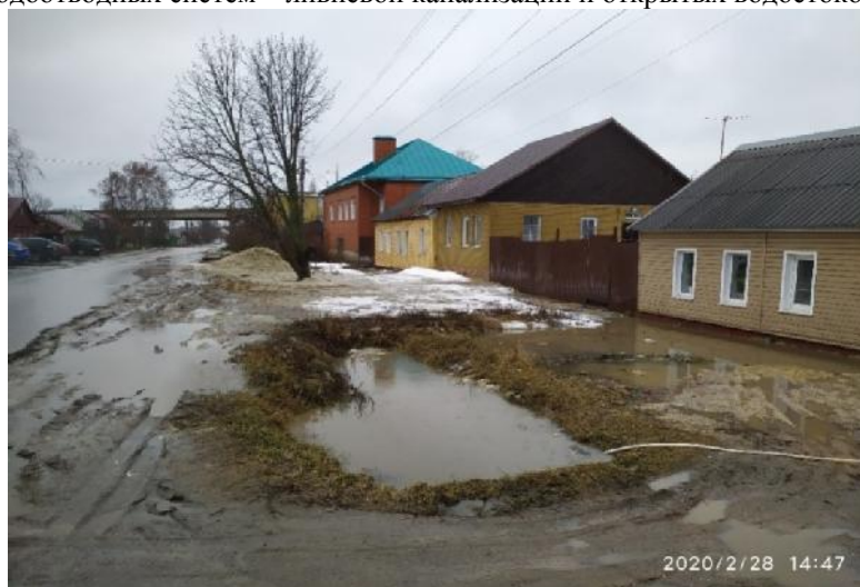
Рисунок 2 – Подтопление территории в месте прохождения водоотводной канавы по ул. Железнодорожной г. Тамбова, в результате ее засыпки.
