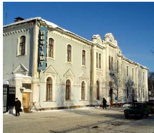
Рисунок 10 - Пристройка (поздняя с правой стороны главного фасада) здания «Почтамт», г. Тамбов
