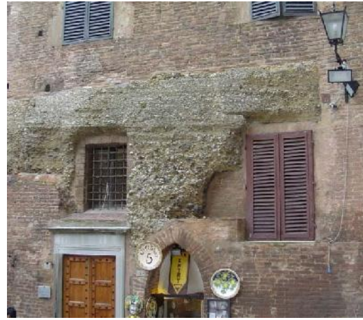
Рисунок 2 - Пример трансформации фасада здания объекта культурного наследия при приспособлении под жилое здание в г. Флоренция, Италия
