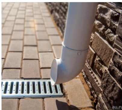
Рис. 6.2. Выпуск водостоков на отмостку:
