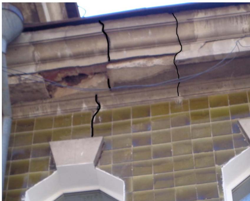
Рисунок 78 – Трещины на уличном фасаде здания в карнизной части
