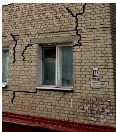
Рисунок 96 – Трещины на уличном фасаде
