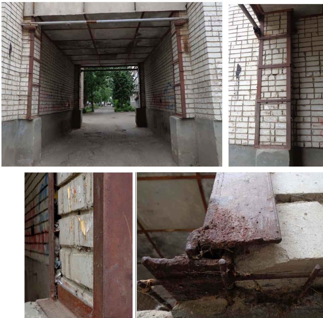
Рисунок 142 – Усиление кладки стальными обоймами в здании по ул. Ф. Энгельса, 4
