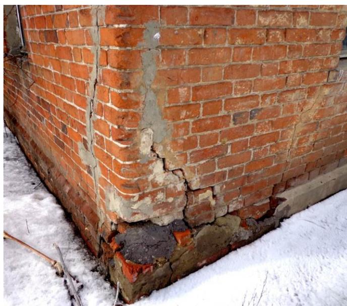
Рисунок 134 – Трещины на восточном фасаде здания
