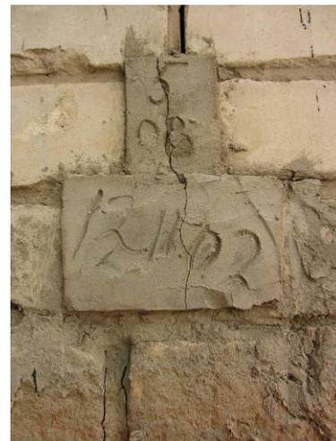
Рисунок 92 – Трещины на главном здании
