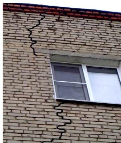
Рисунок 97 – Трещины на дворовом фасаде здания
