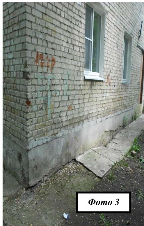
Рисунок 114 – Дефекты и повреждения на западном фасаде здания
