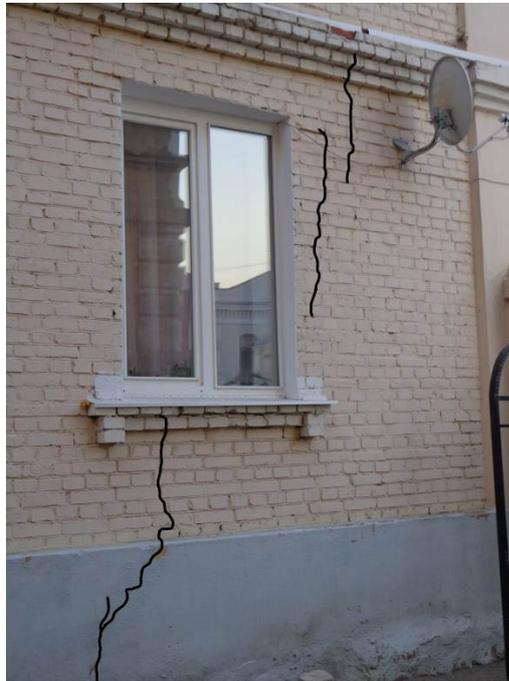
Рисунок 47 – Трещины на боковом фасаде здания
