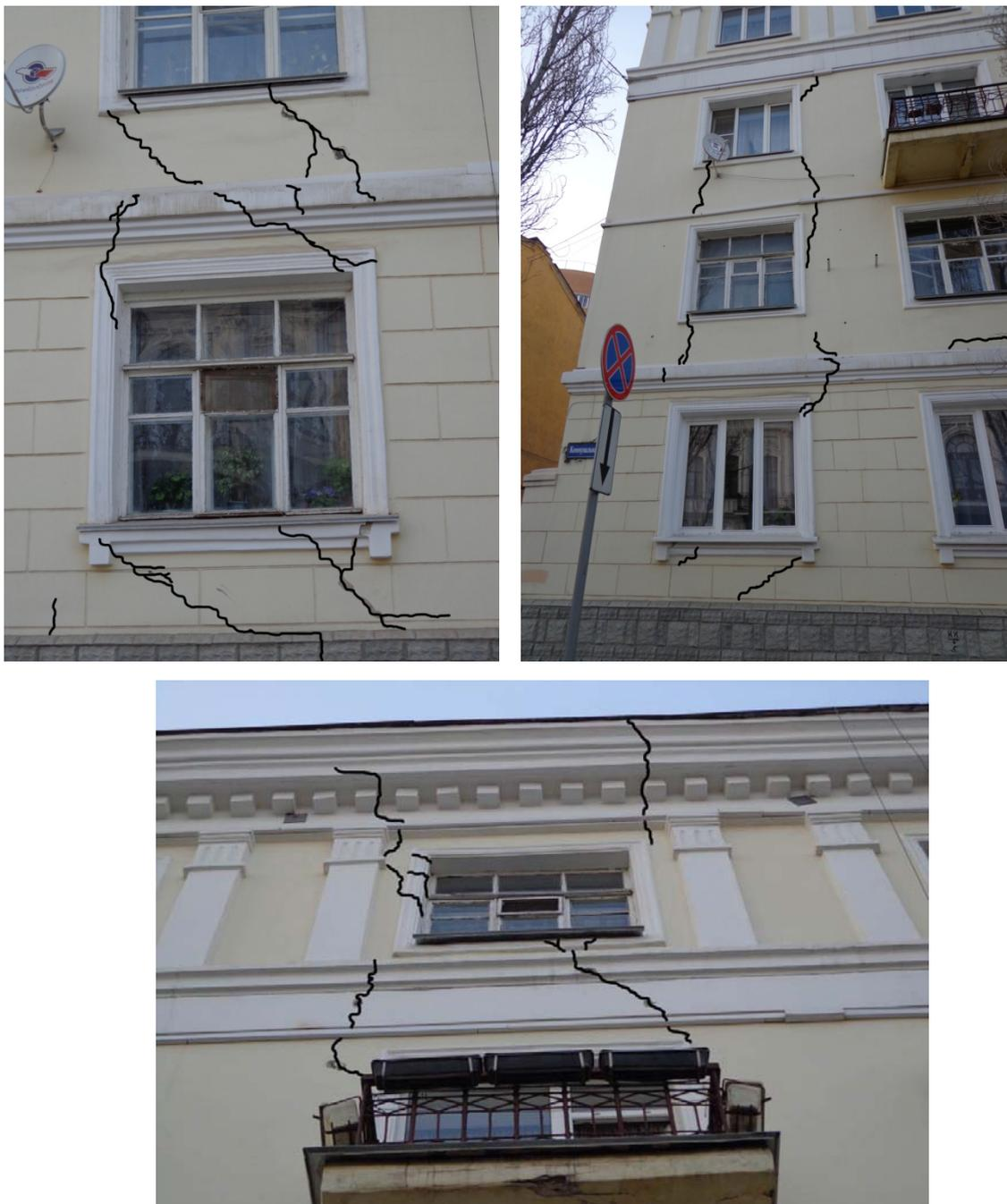
Рисунок 45 – Трещины на уличном фасаде здания
