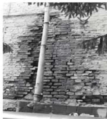
**Рис. 9. Разрушение кирпичной кладки в районе водосточной трубы**
