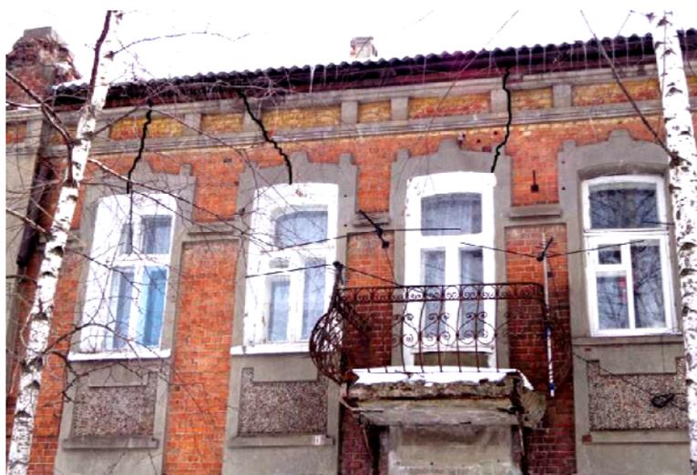
Рисунок 135 – Трещины на уличном фасаде здания
