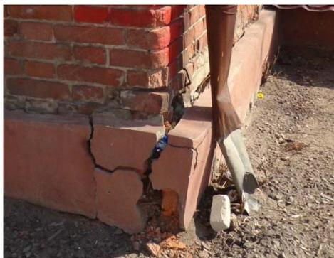
Рисунок 76 – Разрушение цокольной части зданий
