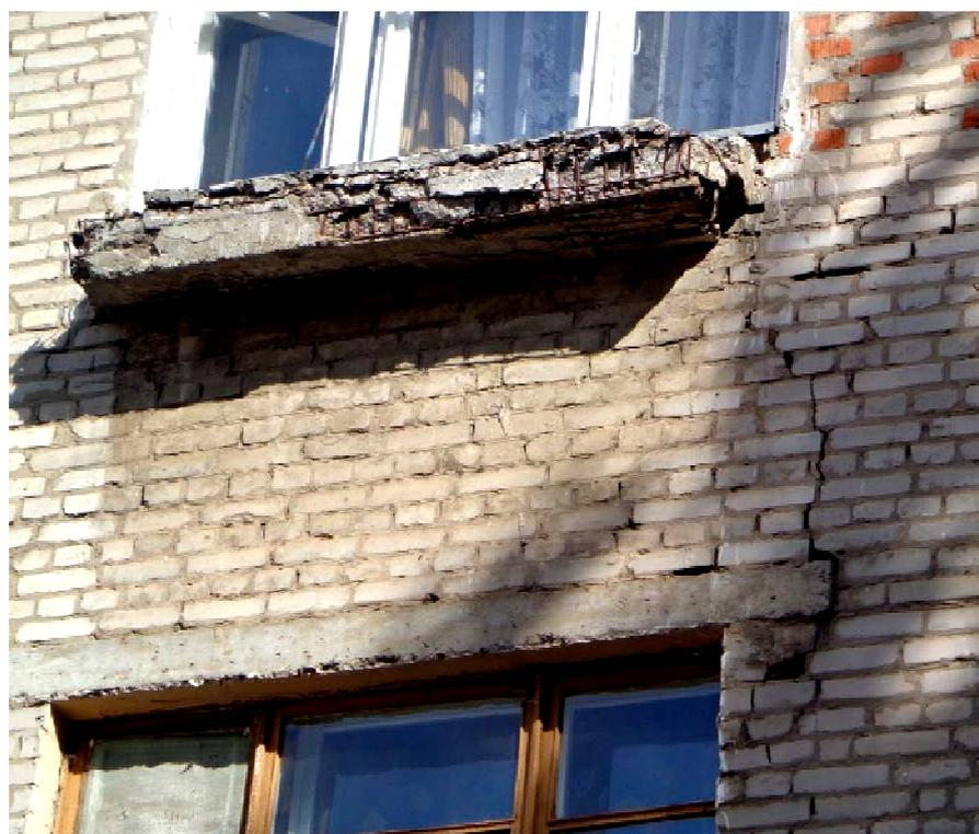
Рисунок 44 – Трещины на дворовом фасаде здания
