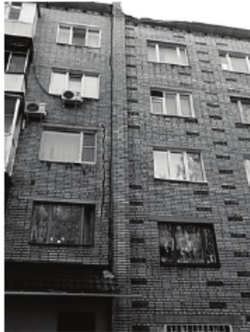
Рис. 1. Трещина на западном фасаде
