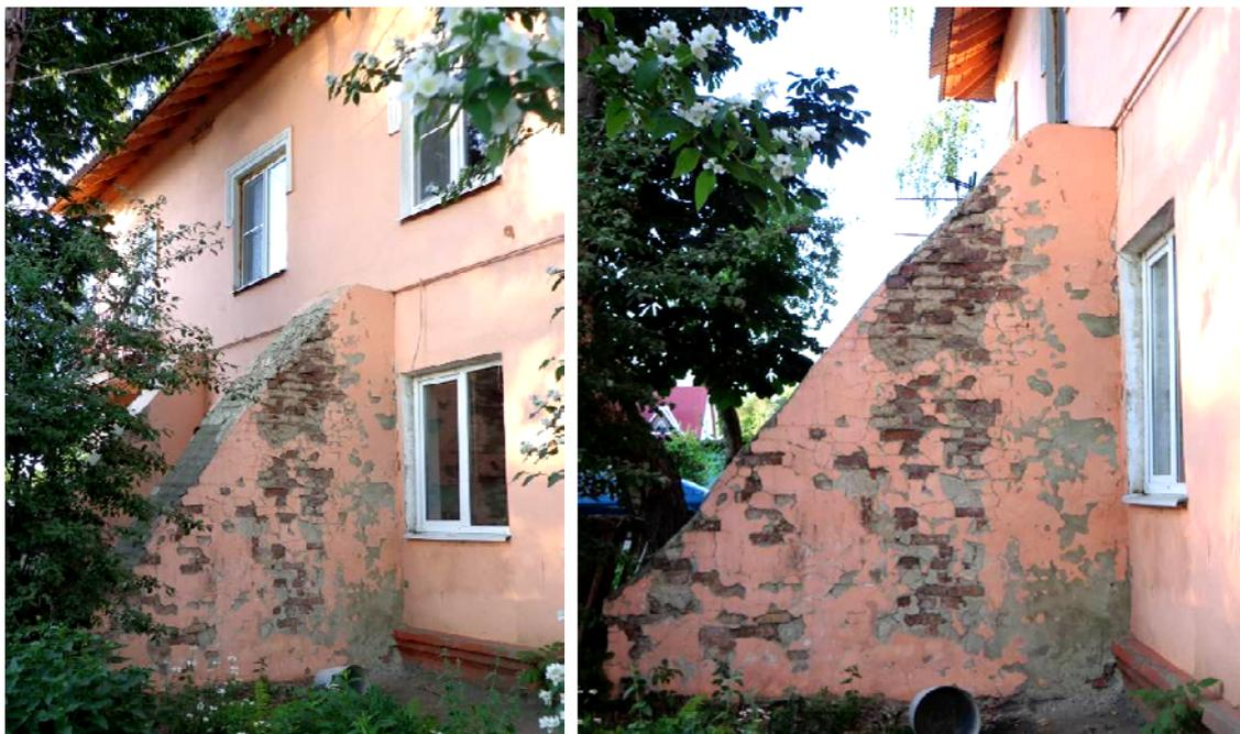
Рисунок 139 – Усиление стены здания по ул. Н. Вирты, 1 контрфорсами
