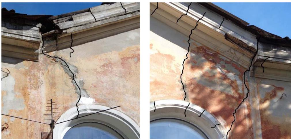
Рисунок 109 – Фрагменты трещин на фасаде со стороны Нового проезда
