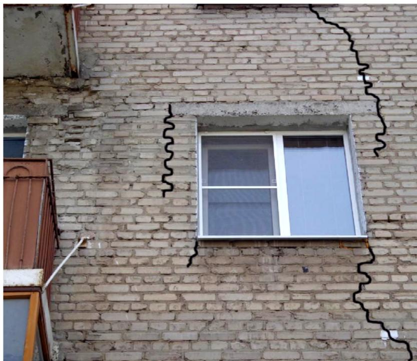
Рисунок 94 – Трещины на уличном фасаде здания
