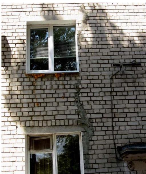
Рисунок 82 – Трещина на южном фасаде
