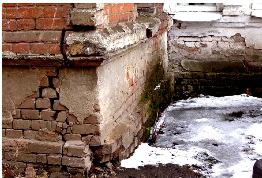
Рисунок 63 – Разрушение цокольной части зданий
