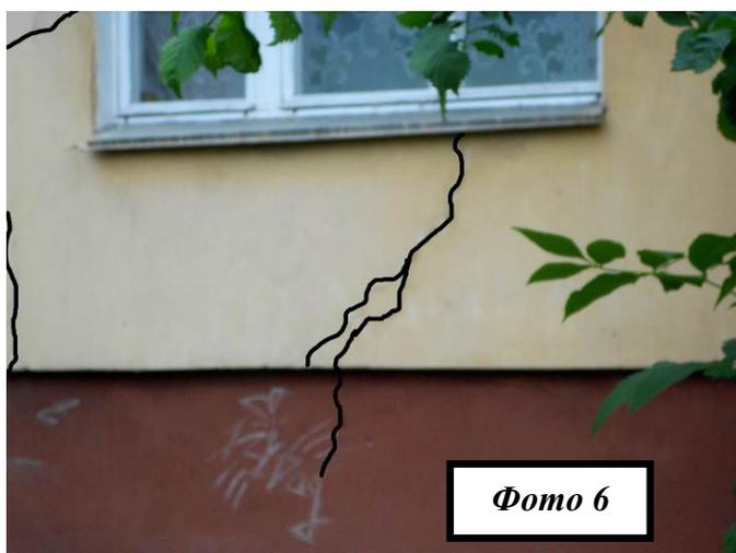
Рисунок 112 – Дефекты и повреждения на восточном фасаде
