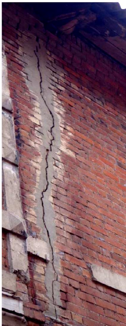
Рисунок 64 – Трещина на боковом фасаде здания
