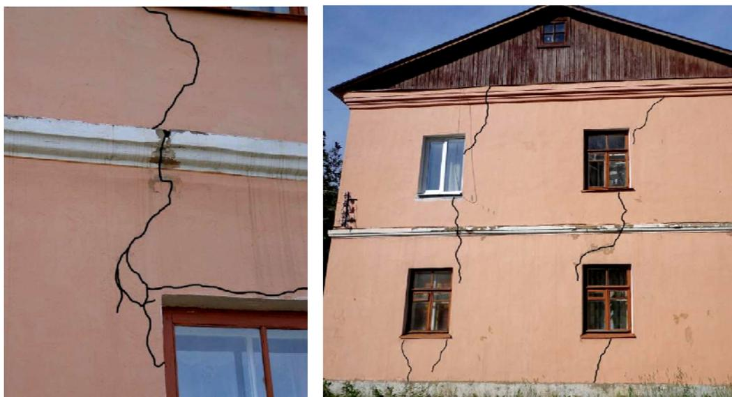
Рисунок 121 – Трещины на стенах до устройства напрягаемого пояса и ремонта фасадов
