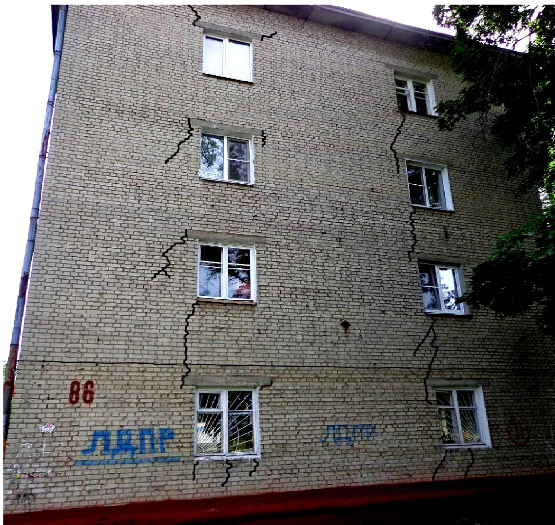
Рисунок 95 – Трещины на боковом фасаде здания
