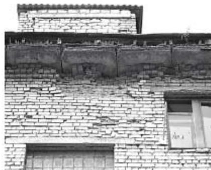
**Рис. 8. Разрушение кирпичной кладки под карнизными плитами**
