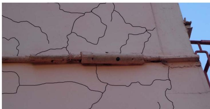
Рисунок 138 – Усиление здания по ул. Н. Вирты, 1 стальным поясом
