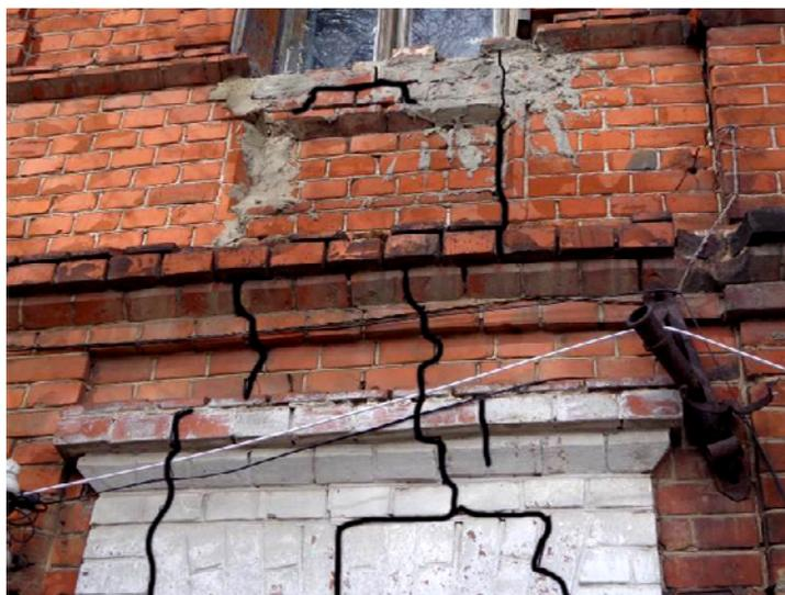
Рисунок 69 – Трещины на уличном фасаде здания
