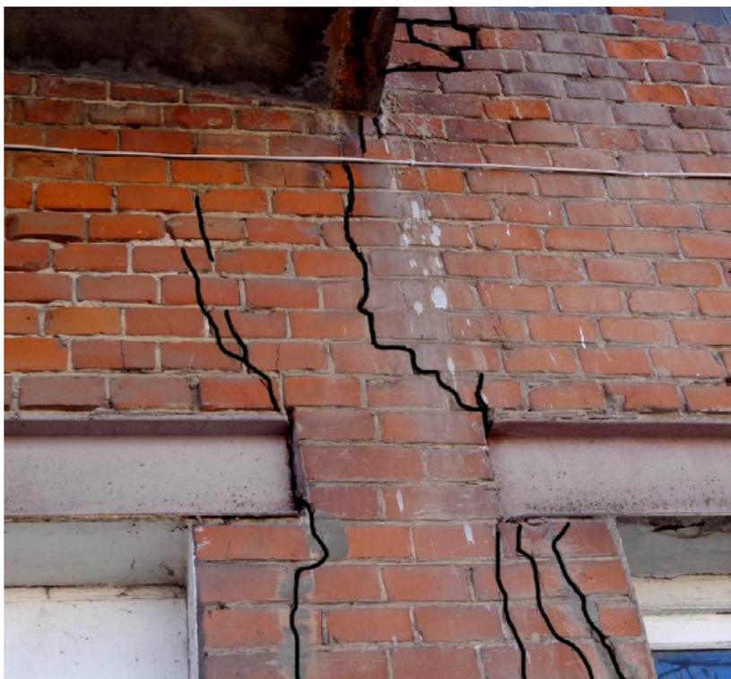
Рисунок 77 – Трещины на уличном фасаде здания
