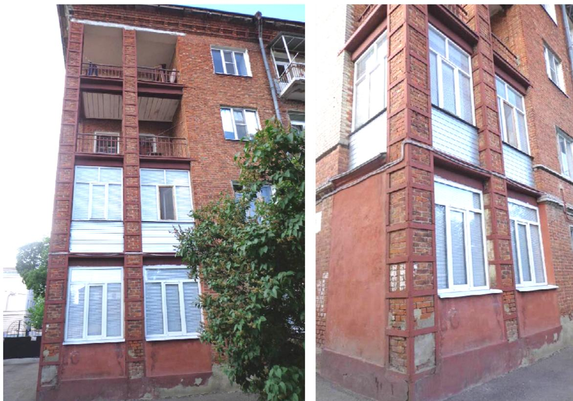
Рисунок 141 – Усиление колонн стальными обоями
