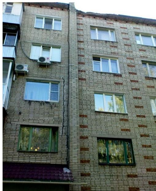
Рисунок 50 – Трещина на западном фасаде здания
