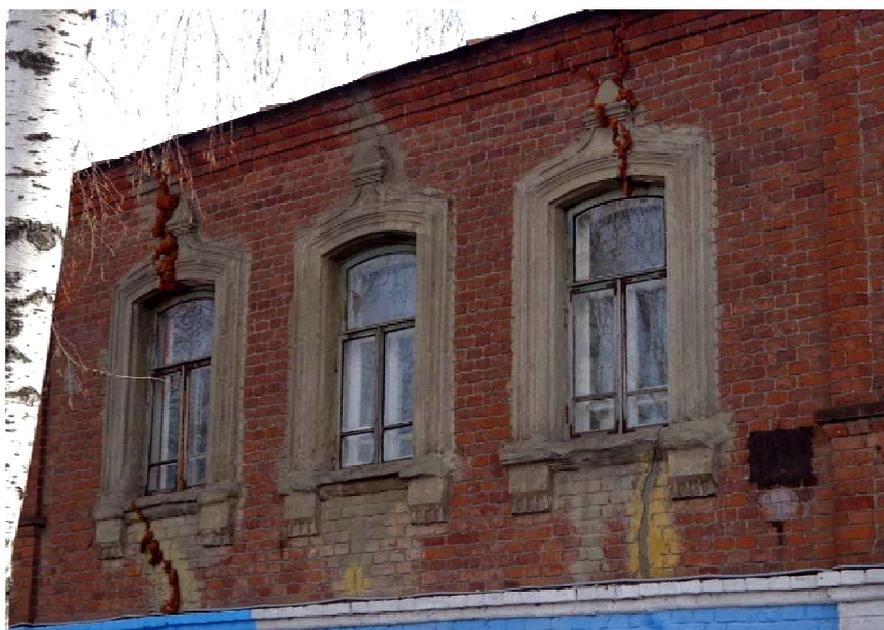
Рисунок 72 – Трещины над оконными проемами и под ними
