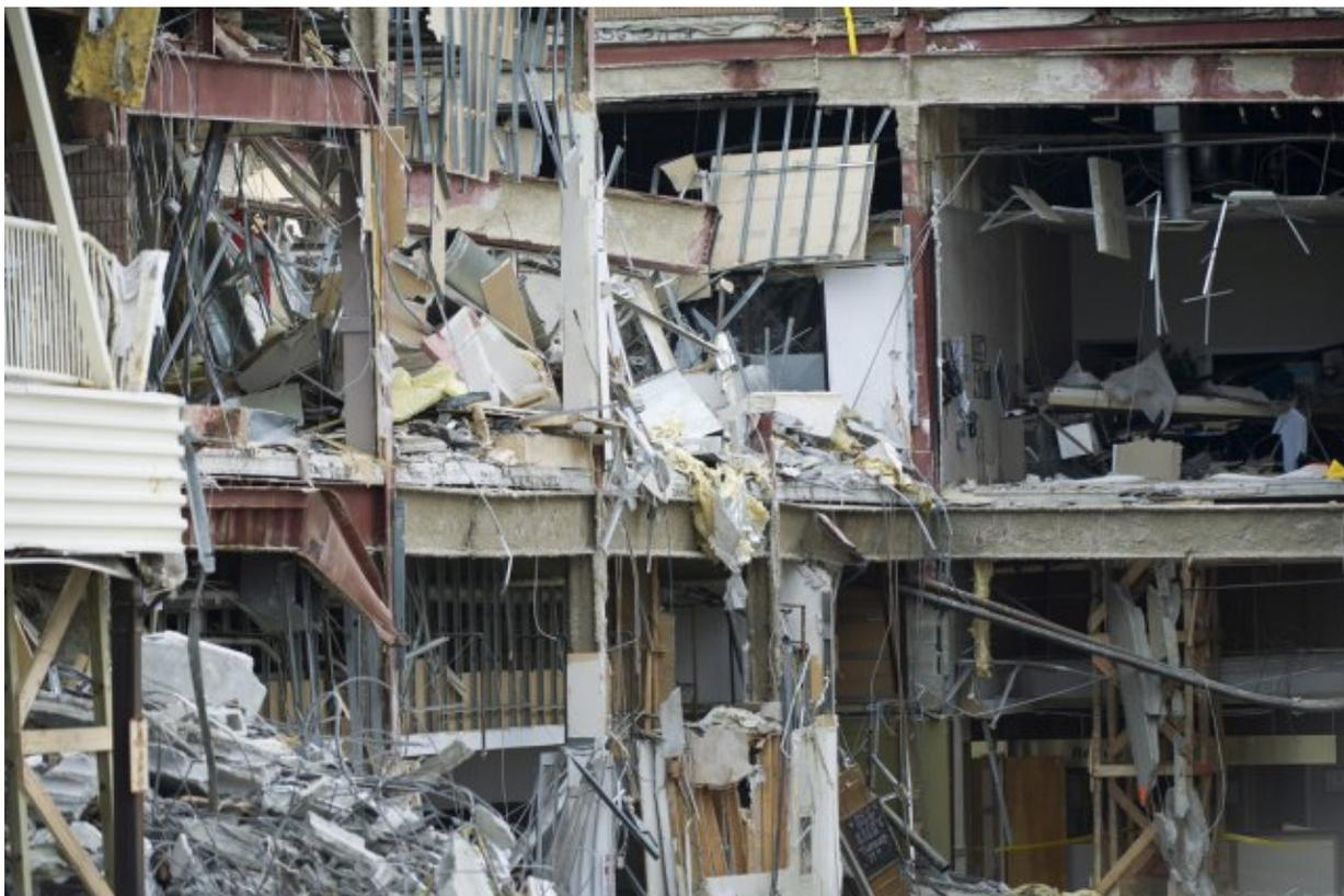
Рисунок 51 Обрушение крыши и парковки ALGO Centre Mall
