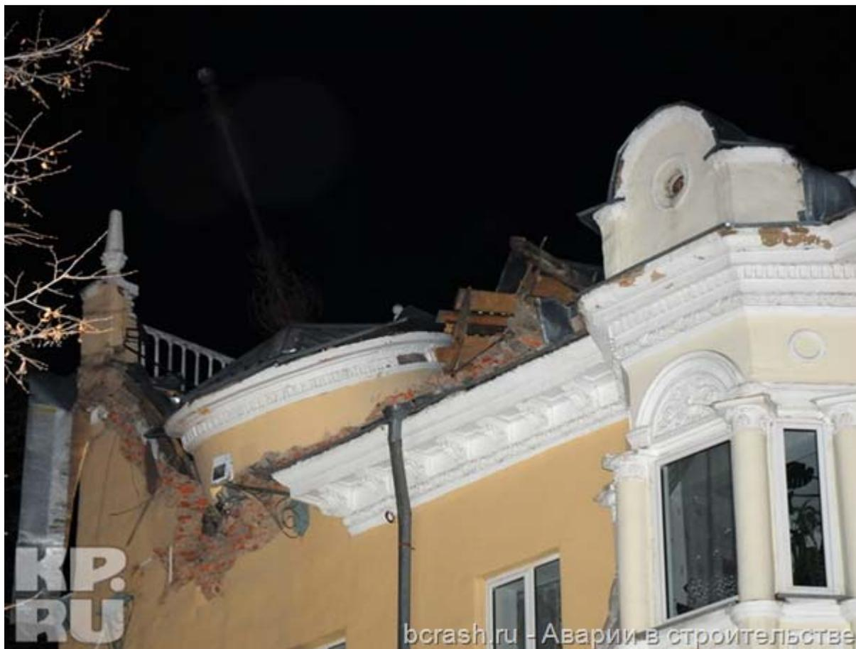
Рисунок 24 Обрушенная башня
