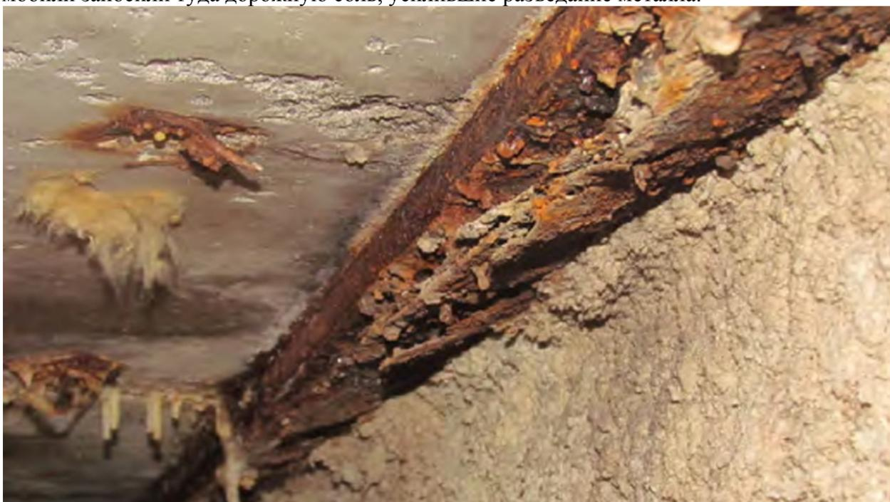
Рисунок 52 Здесь видны коррозионные процессы в бетоне и металлоконструкциях супермаркета ALGO Centre Mall
