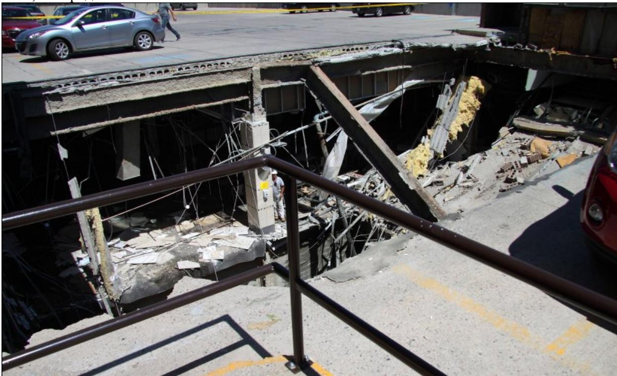
Рисунок 50 Обрушение крыши и парковки ALGO Centre Mall
