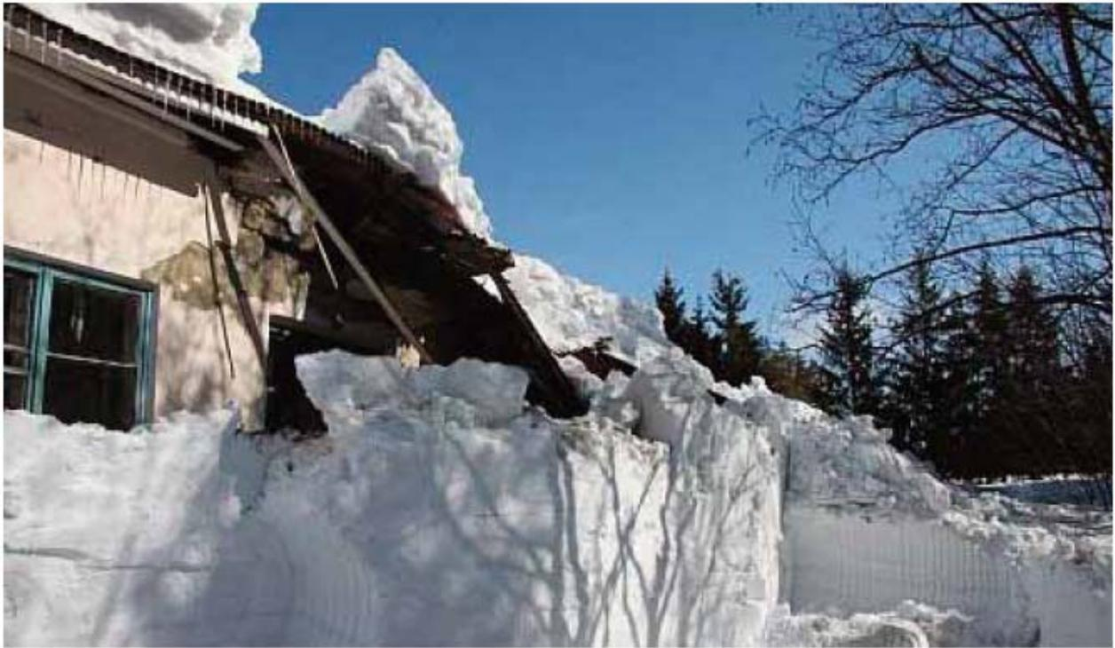
Рисунок 16 Обрушение крыши здания общеобразовательной школы в селе Пятиречье Сахалинской области
