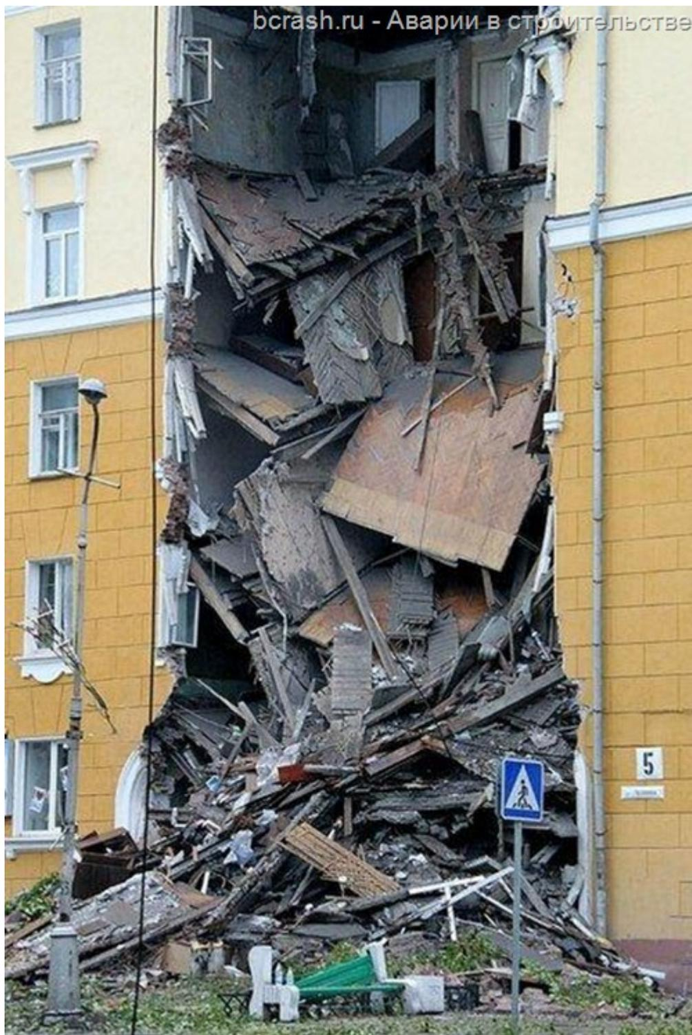
Рисунок 19 Обрушение секции жилого пятиэтажного дома в г. Северодвинск
