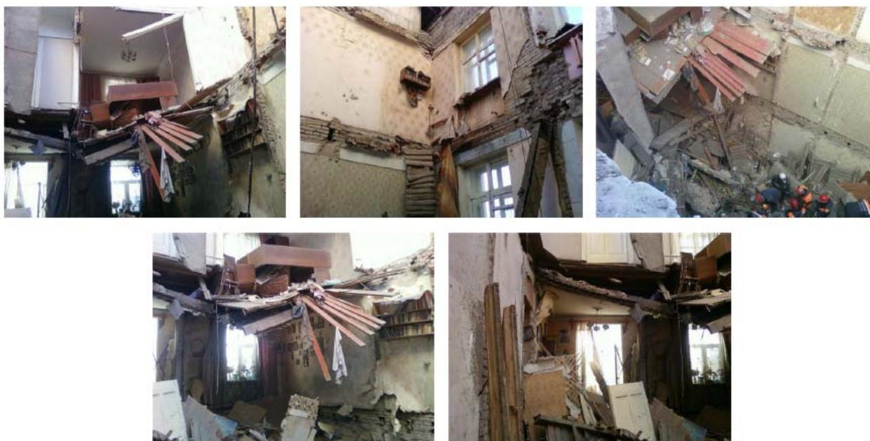
Рисунок 10 Обрушение подьезда четырехэтажного жилого дома в Ярославле
