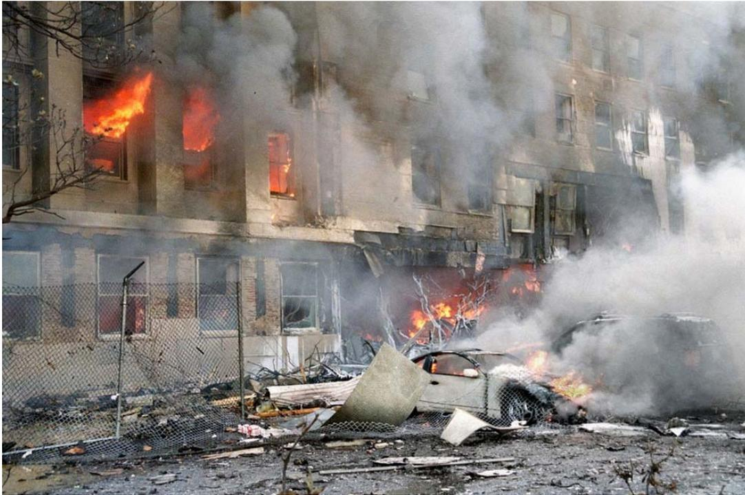
Рисунок 93 Вид фасада наружного кольца здания Пентагона в первые минуты после удара самолета и взрыва топлива (прогрессирующего обрушения конструкций еще не произошло)
