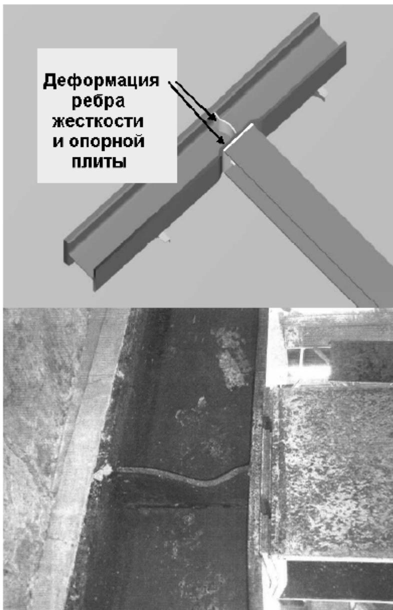
Рисунок 40 Выгиб ребра жесткости и опорной части в месте примыкания распорки к обвязочному поясу до случившейся аварии
