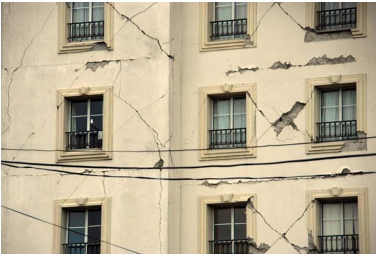
Рисунок 74 Трещины поползли по дому после землетрясения в Порт-о-Пренс 12 января. (Clarens Renois / AFP - Getty Images)
