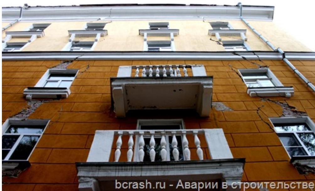
Рисунок 20 Развитие трещин накануне обрушения
