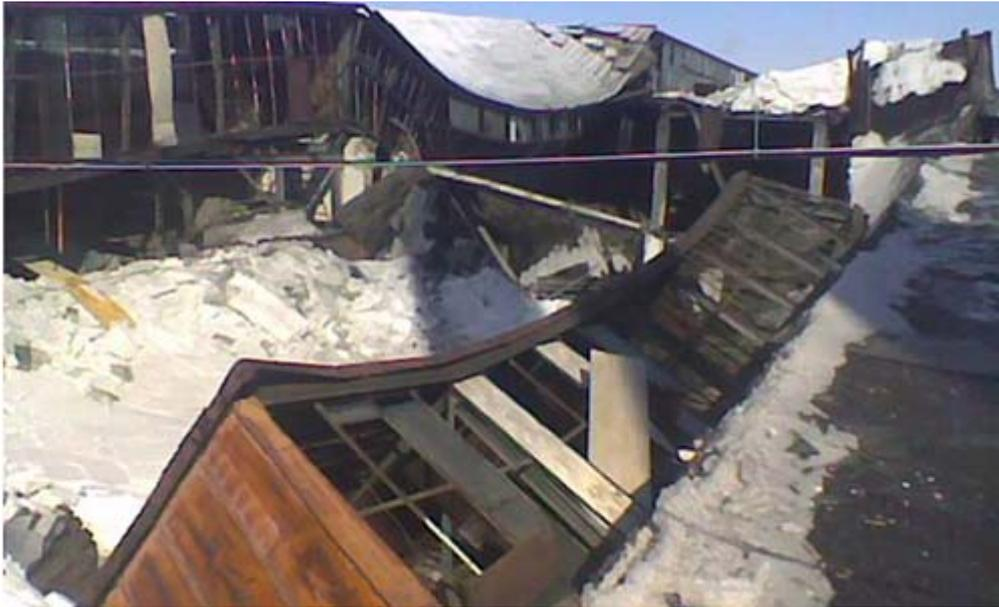
Рисунок 27 Обрушение крыши производственного цеха
