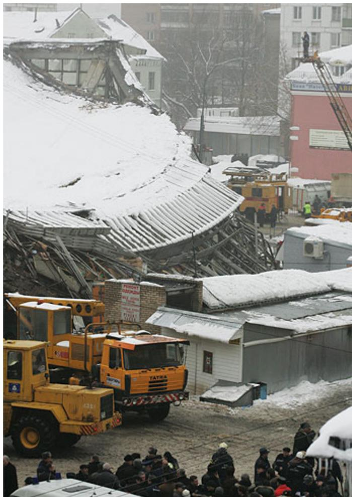
Рисунок 49 Обрушение кровли Басманного рынка
