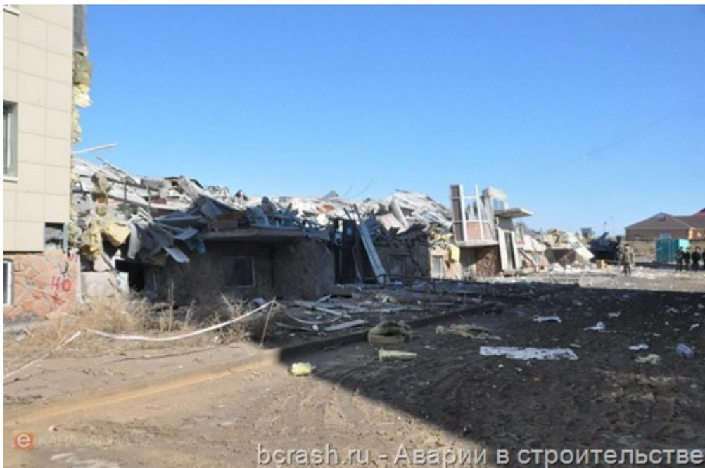
Рисунок 26 обрушение здания в жилом комплексе «Бесоба»
