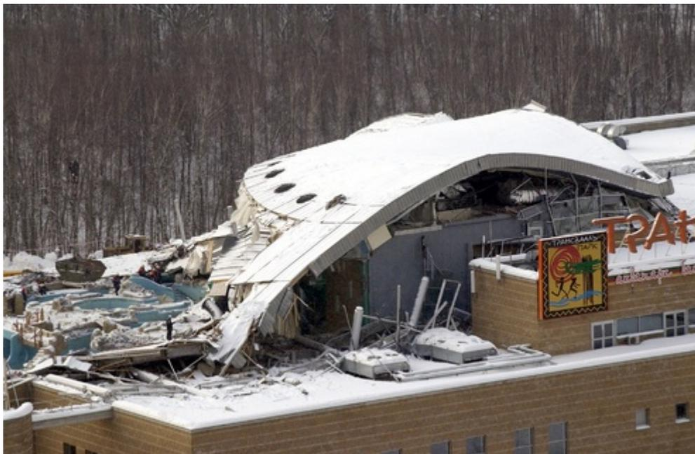
Рисунок 2 Обрушение покрытия «Трансвааль парка»
