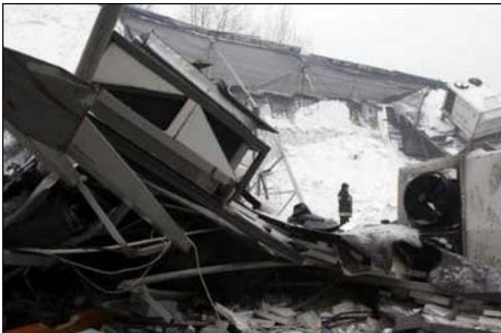
Рисунок 31 Обрушение крыши торгово-выставочного комплекса
