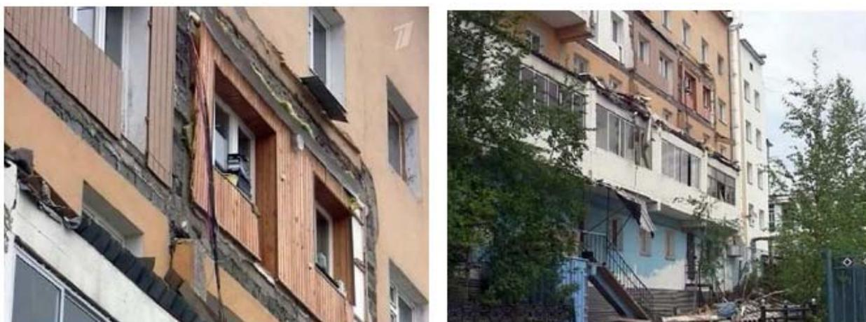
Рисунок 12 Обрушение трех балконов пятиэтажного жилого дома в г.Якутске
