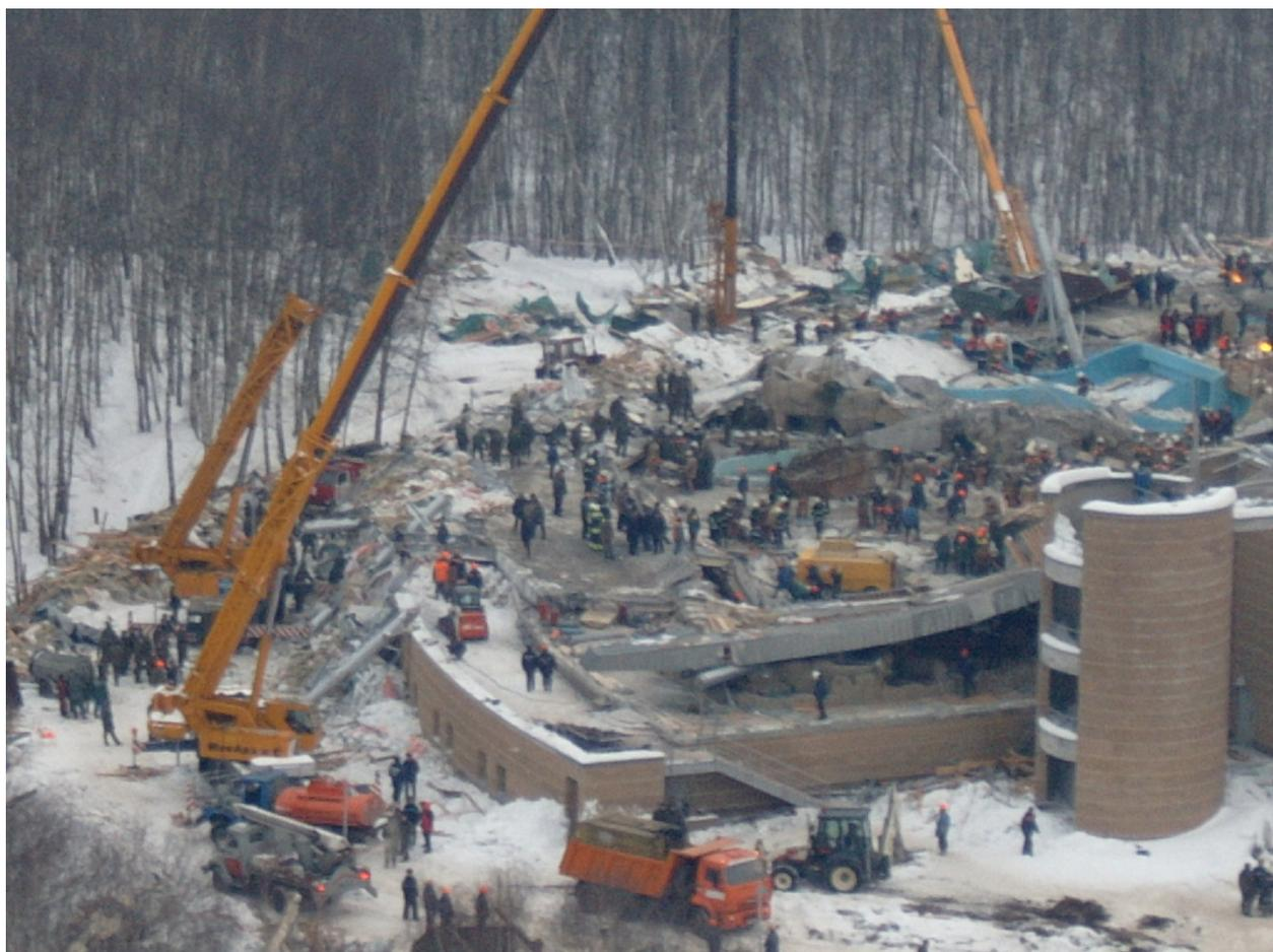
Рисунок 41 Обрушение купола «Трансвааль-парка»
