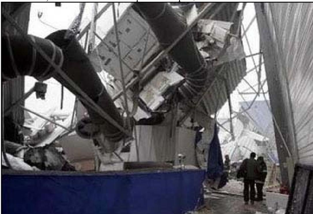
Рисунок 32 Обрушение крыши торгово-выставочного комплекса
