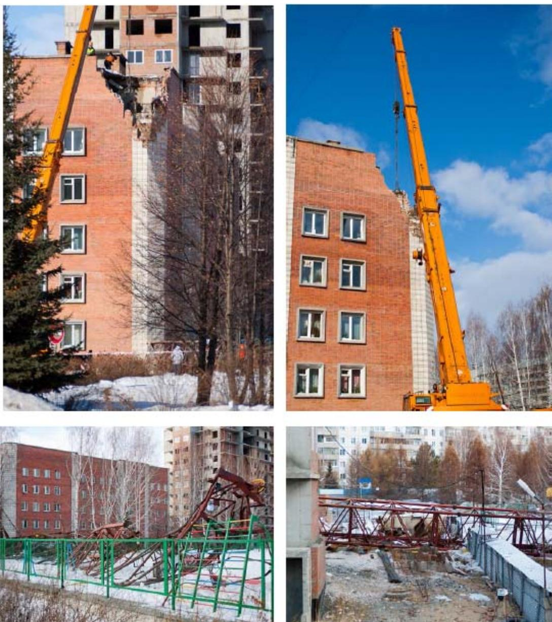
Рисунок 13 Падение строительного крана на жилой дом, г.Якутск
