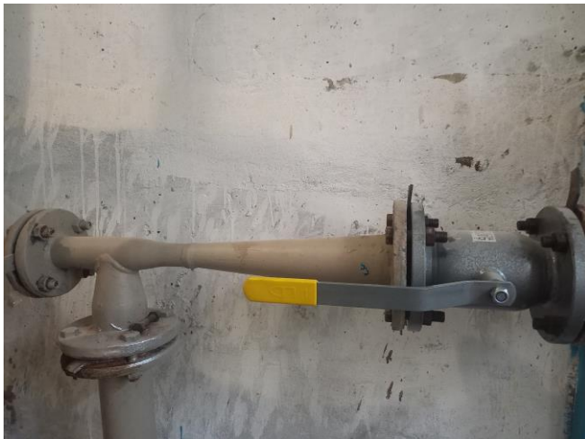
Рис. 1.7. Элеваторный узел
