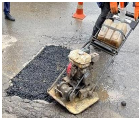
Рис. 4. Ремонт выбоины с использованием разогревателя
