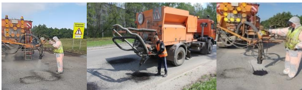
Рис. 3. Подготовка места к ремонту выбоины и заполнение выбоины смесью
