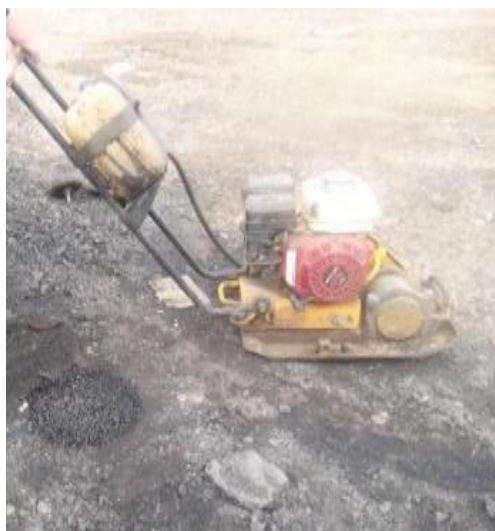
Рис. 4. Уплотнение смеси в выбоине покрытия при струйно-инъекционном методе
