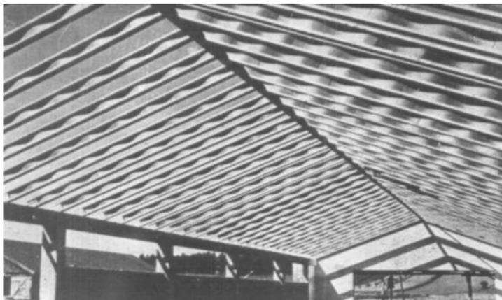
**Рис. 1.5. Балки с волнистой фанерной стенкой**
