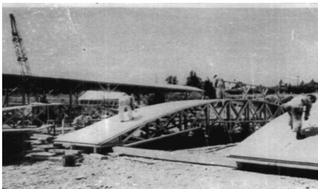
**Рис. 1.10. Элементы фанерного свода пролетом 18,5 м**
