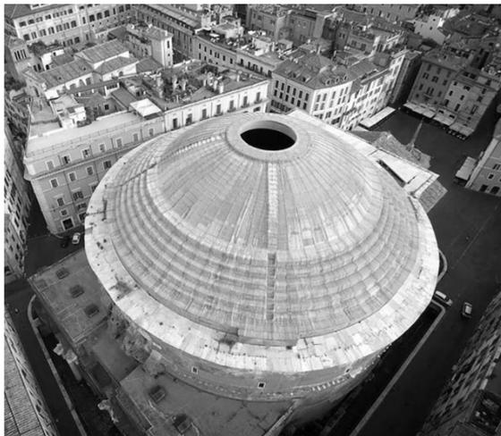
Кирпично-бетонная **ротонда Пантеона** перекрывается полусферическим куполом (диаметр 43,3 м). Почти две тысячи лет после его постройки купол Пантеона по-прежнему является крупнейшим в мире неармированным бетонным куполом [5].
