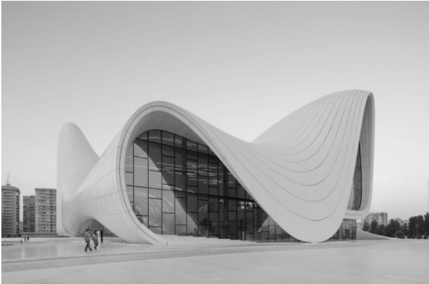
**Heydar Aliyev Center (Азербайджан, Баку, архитектор Заха Хадид, 2012 г.)** состоит из двух систем – бетонной конструкции и большого количества пространственных рам. Для создания больших пространств, позволяющих посетителю почувствовать плавность интерьера, вертикальные элементы конструкции скрыты системой ограждающих панелей и навесных стен.
