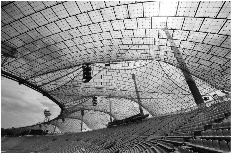
**Олимпиаштадион (Мюнхен, архитекторы Фрай Отто, Гюнтер Бениш, 1972 г.)** Архитекторы использовали листы плексигласа, толщиной 7 мм. Каждый лист крепился на вантовой сетке в девяти точках. Листы монтировались в рамках из алюминиевого сплава и стыковались между собой с помощью жестких водонепроницаемых прокладок из неопрена [16].
