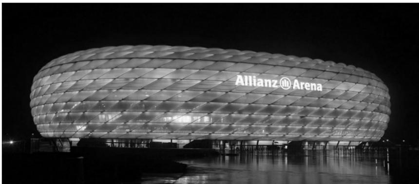
С использованием ЭТФЭ (ETFE) был возведен **футбольный стадион «Альянс Арена»** в Мюнхене, строительство было завершено в 2005 г. Фасад из пневмолинз был запроектирован архитекторами Херцогом и Мауроном. Он состоит из 2760 ромбовидных подушек из ЭТФЭ на общей площади 66 тыс. м<sup>2</sup>. Позади пневмолинз располагаются люминесцентные трубки, обеспечивающие красную, голубую или белую подсветку здания [1].
