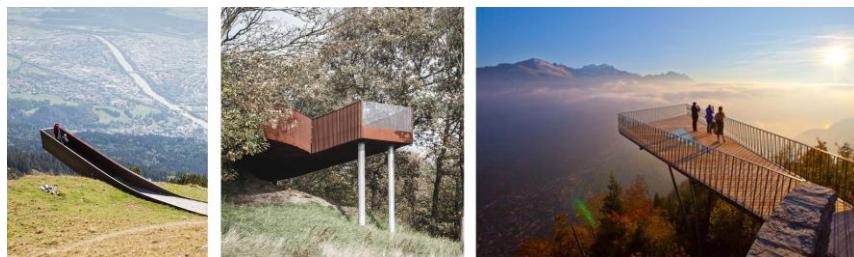
Рис. 6. Смотровые площадки типа «Консоль»
